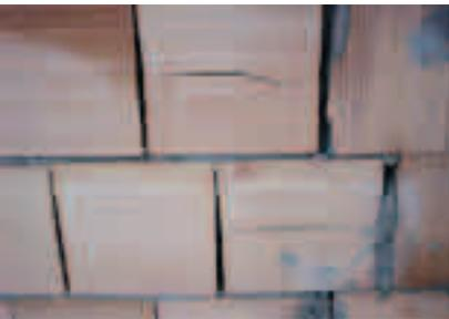
Frequente errore nella realizzazione del giunto di malta. Non vi è posizionamento di malta e la struttura disperde molto calore e rumore attraverso questi varchi
